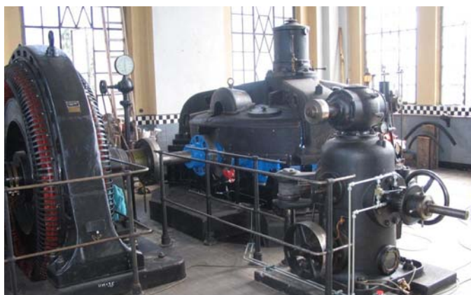
Strojovna MVE Poděbrady po rekonstrukci
